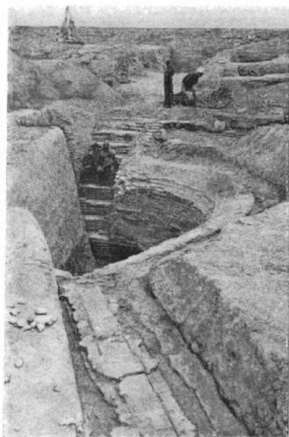
Рис. 10. Талайхан-ата. 1 — цистерна (сардоба); 2 — водопроводный желоб, подводивший воду в караван-сарай с окружающих такыров
